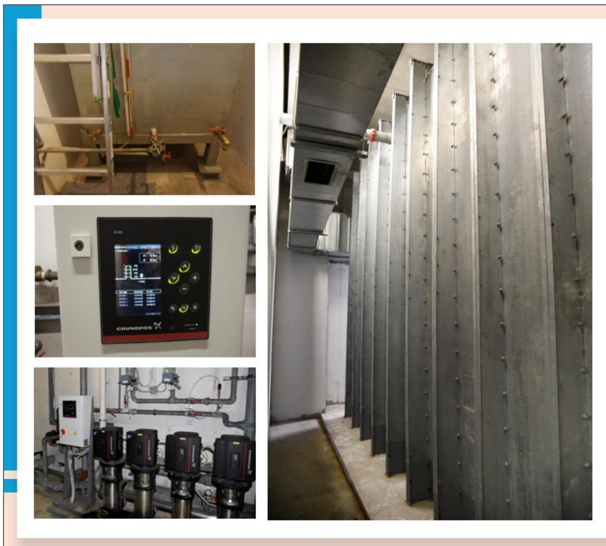
Εικόνα 7: Δεξαμενή ύδρευσης & εγκαταστάσεις διανομής του «The Mall Athens»
