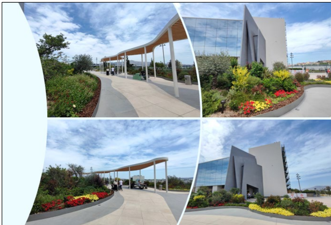
Εικόνα 4: Κύρια είσοδος του «The Mall Athens» μετά την ολοκλήρωση των εργασιών απομάκρυνσης του γυάλινου πύργου και την δημιουργία φυτεμένων χώρων
