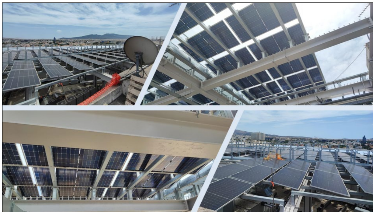
Εικόνα 9: Εγκατάσταση Φ/Β panels στην ταράτσα του Εμπορικού και Ψυχαγωγικού Κέντρου «The Mall Athens»
