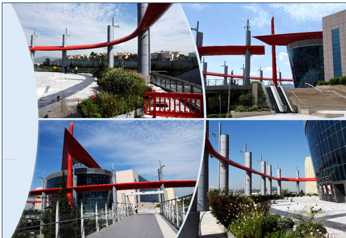
Εικόνα 3: Περιβάλλον χώρος στο Εμπορικό και Ψυχαγωγικό Κέντρο «The Mall Athens» πριν τις εργασίες κατεδάφισης του γυάλινου πύργου
