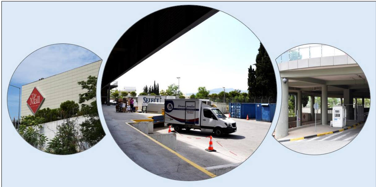
Εικόνα 9: Εξωτερικός χώρος - loading bays του Εμπορικού και Ψυχαγωγικού Κέντρου «The Mall Athens»
